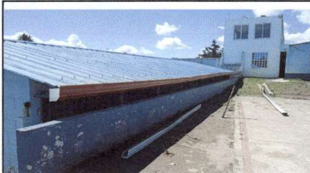
Foto 8: sustitucion de canales de pvc. Modulo 3 de aulas
