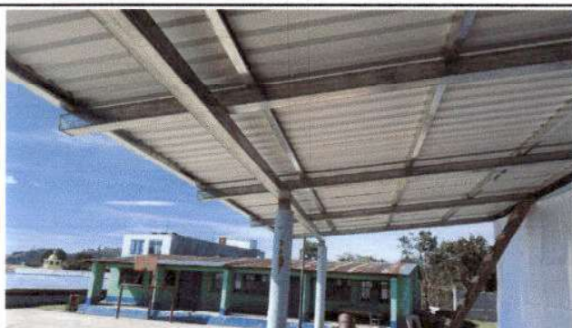
Foto 3: sustitución de estructura de soporte de madera, por metal modulo 2 de aulas.
