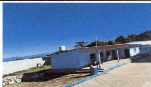
Foto 2: Sustitución de lámina, por lámina troquelada calibre 26, sustitución de capote de lámina para lámina troquelada, sustitución de elementos de fijación. Modulo 2 de aulas.
