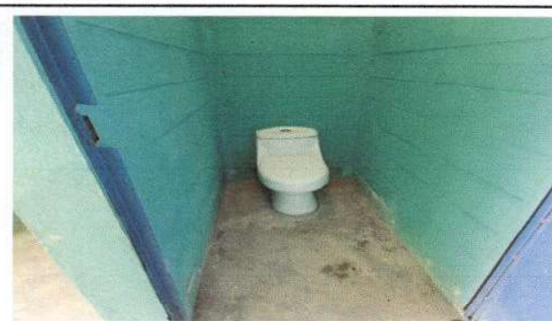
Foto 4: sustitución de inodoros modulo de baños.
