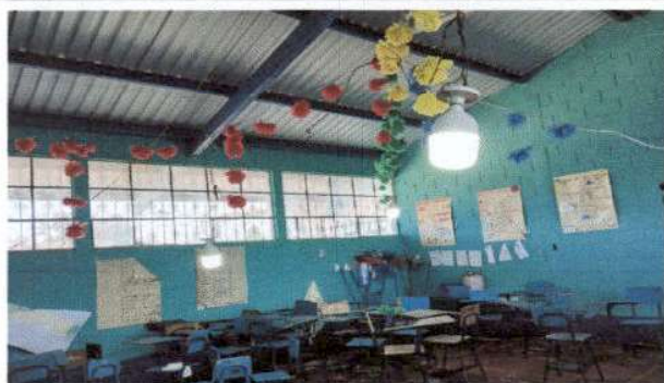
Foto 9: sustitucion de focos ahorradores modulos de aulas.
