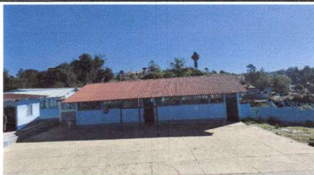
Foto 1: Sustitución de lámina, por lámina troquelada calibre 26, sustitución de capote de lámina para lámina troquelada, sustitución de elementos de fijación. Modulo 1 de aulas.
